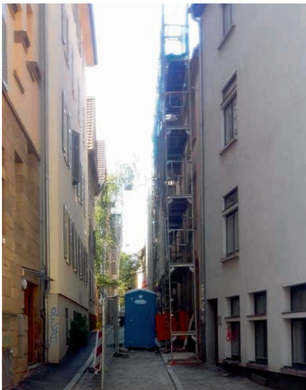
4 + 5 | Beengte Verhältnisse bei einer Gebäudesanierung: Eine Durchgangsbreite von 1,5 m musste ebenso gewährleistet werden wie die Sicherung des Bauzauns mit den notwendigen Verkehrszeichen.
