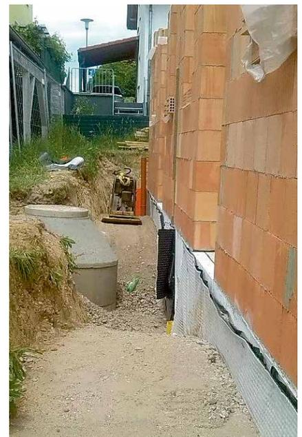
**3 + 4 + 5** | Eine Mehrsparte mit Anschlussstücken, die verlängert werden können. Hier ist darauf zu achten, dass kein zu enger Boden erzeugt wird (max. 15° Bögen). Anschließend können die ersten Lagen aufgefüllt und verdichtet werden. Die Anschlussstücke werden dann mit der nächsten Lage verarbeitet.
