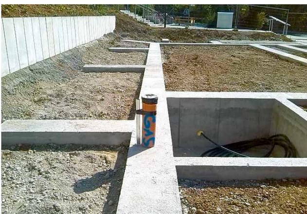
1 + 2 | Geplante Gasverlegung im Leerrohr, Modul mit entsprechender Aussparung
